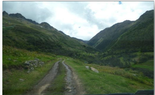
Foto Mejoramiento del acceso vehicular al C.A. Písaq
